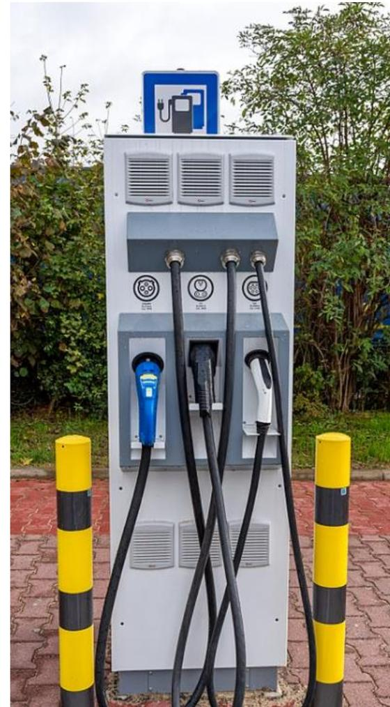
**Ladesäulen mit Typ-2 (AC)-, CCS-Combo-2(DC) und CHAdeMO (DC)-Anschlüssen**
